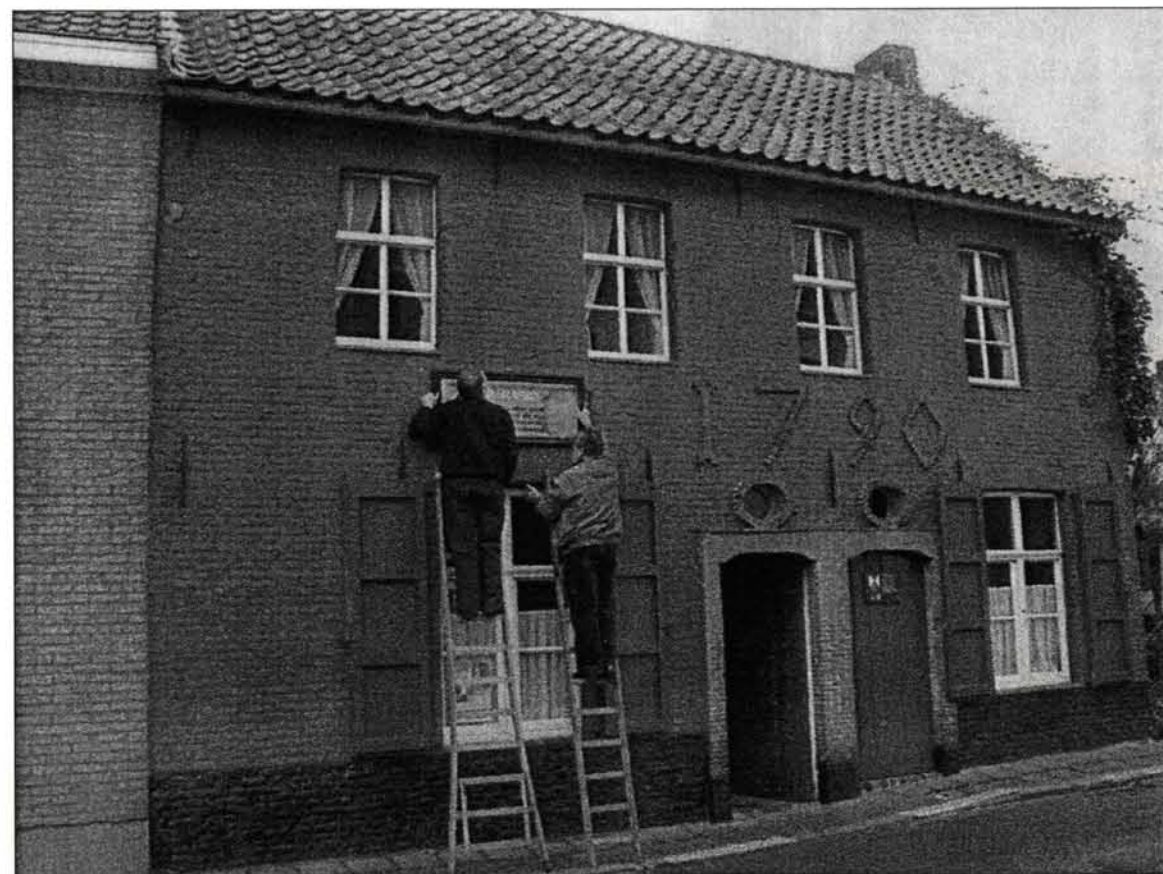
Jacques Goeminne en Arnold Vantieghem bevestigen de nieuwe plaat.
